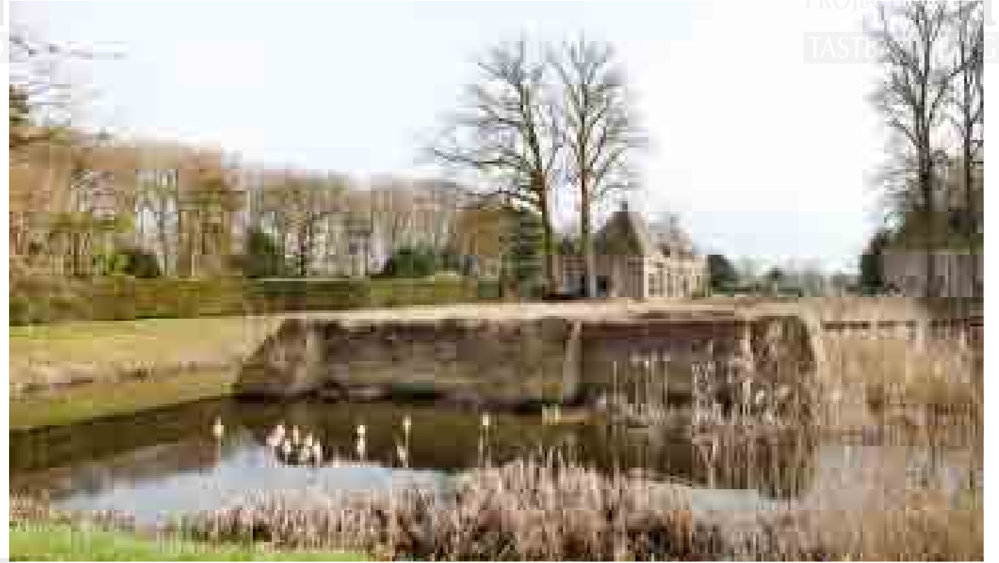
De fundering van het in de Tweede Wereldoorlog gebombardeerde huis van Windesheim te Windesheim met op de achtergrond twee behouden bouwhuizen.
